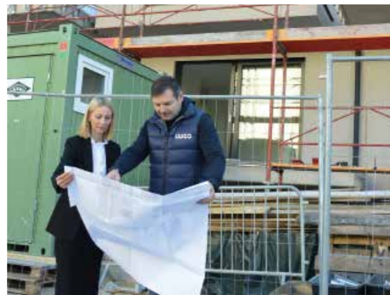
Beatrice Mild-Fuchs und Alexander Török kontrollieren laufend den Baufortschritt der Villa Schönbrunn.
